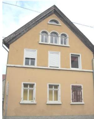
**Vertikale Fassadengliederung bei giebelständigen Gebäuden**
